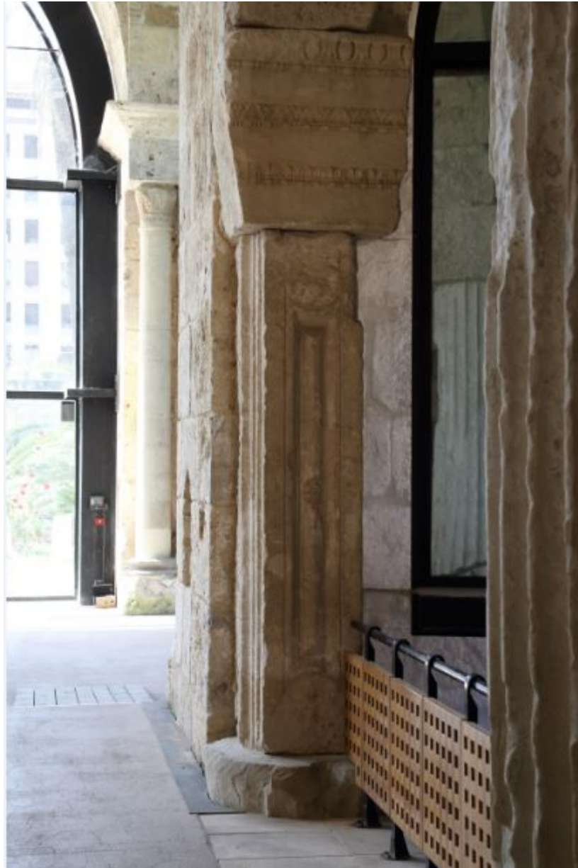
Fig. 1 - Elementi architettonici di reimpiego (trabeazione, architrave) nel setto divisorio della navata sinistra del braccio orientale (foto di Unicity S.p.A.).
