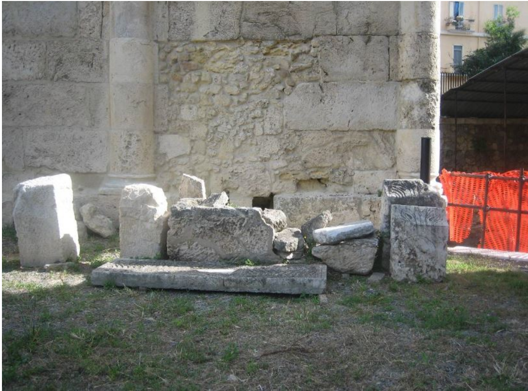
Fig. 2 - Manufatti in pietra lavorata (foto di Unicity S.p.A.).
