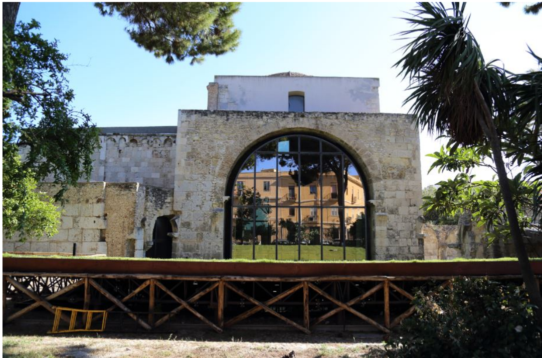
Fig. 3 - Il corpo cupolato: lato nord (foto di Unicity S.p.A.).
