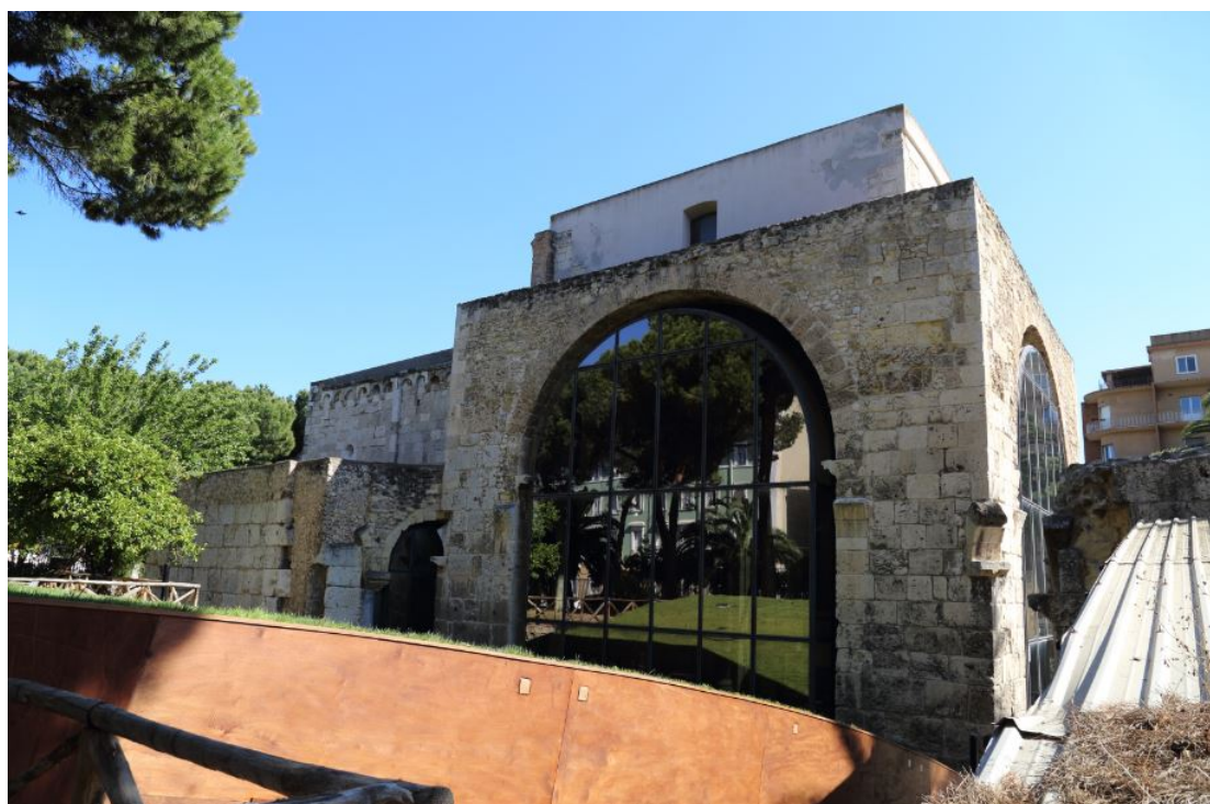
Fig. 2 - Il corpo cupolato e il braccio orientale visti da nord (foto di Unicity S.p.A.).
