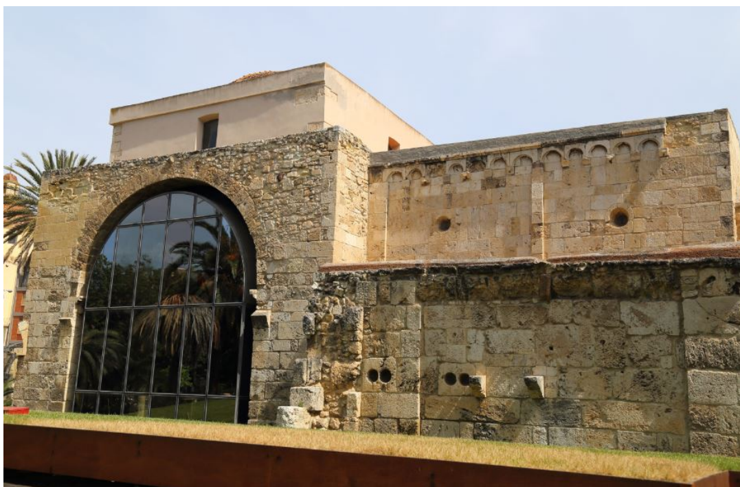
Fig. 1 - Il corpo cupolato e il braccio orientale visti da sud (foto di Unicity S.p.A.).
