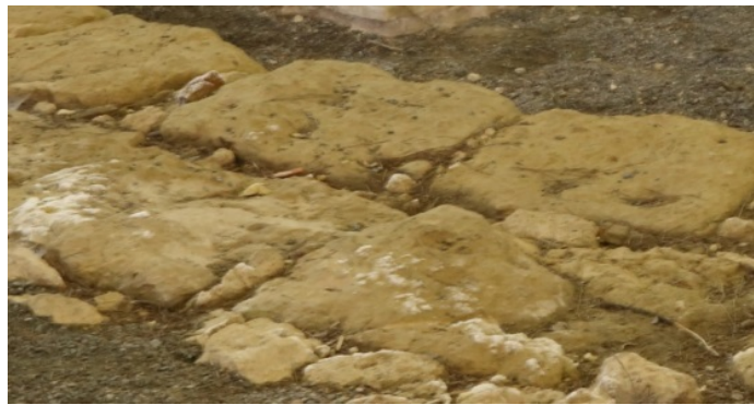
Fig. 3 - "Basilichetta": dettaglio della tecnica costruttiva (foto di Unicity S.p.A.).
