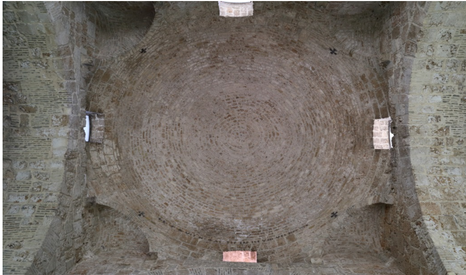
Fig. 8 - La cupola con le scuffie vista dall'interno (foto di Unicity S.p.A.).
