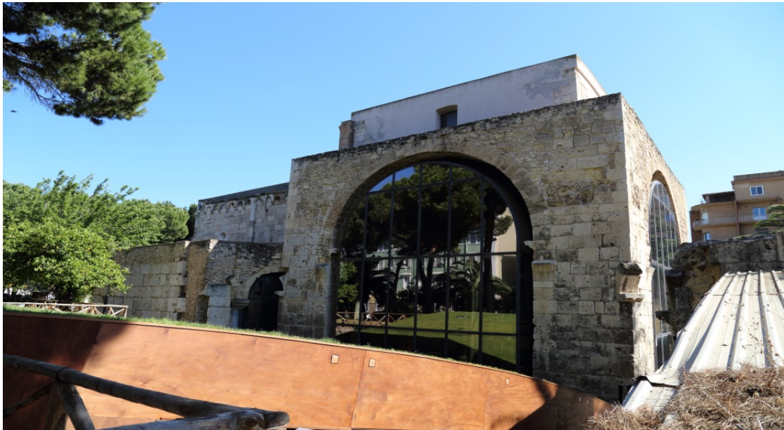
Fig. 7 - Il corpo cupolato visto da Nord (foto di Unicity S.p.A.).
