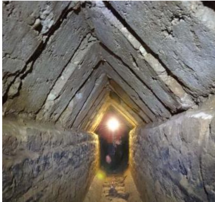
Fig. 4 - Elmas: tratto sotterraneo dell'acquedotto Cabudacquas-Cagliari (da http://www.monumentiaperti.com/it/default/3816/L-acquedotto-romano-Cabudaquas-Cagliari-il-tratto-di-Elmas-e-Azienda-Agraria-dell-I-S-S-Agrario-I-S-S-Agrario-Duca-degli-Abruzzi-.html )
