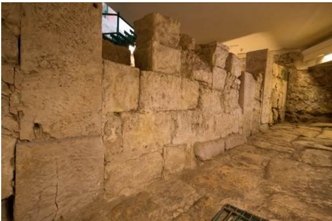
Fig. 1 - Muro in opus africanum (foto di Unicity S.p.A.)
