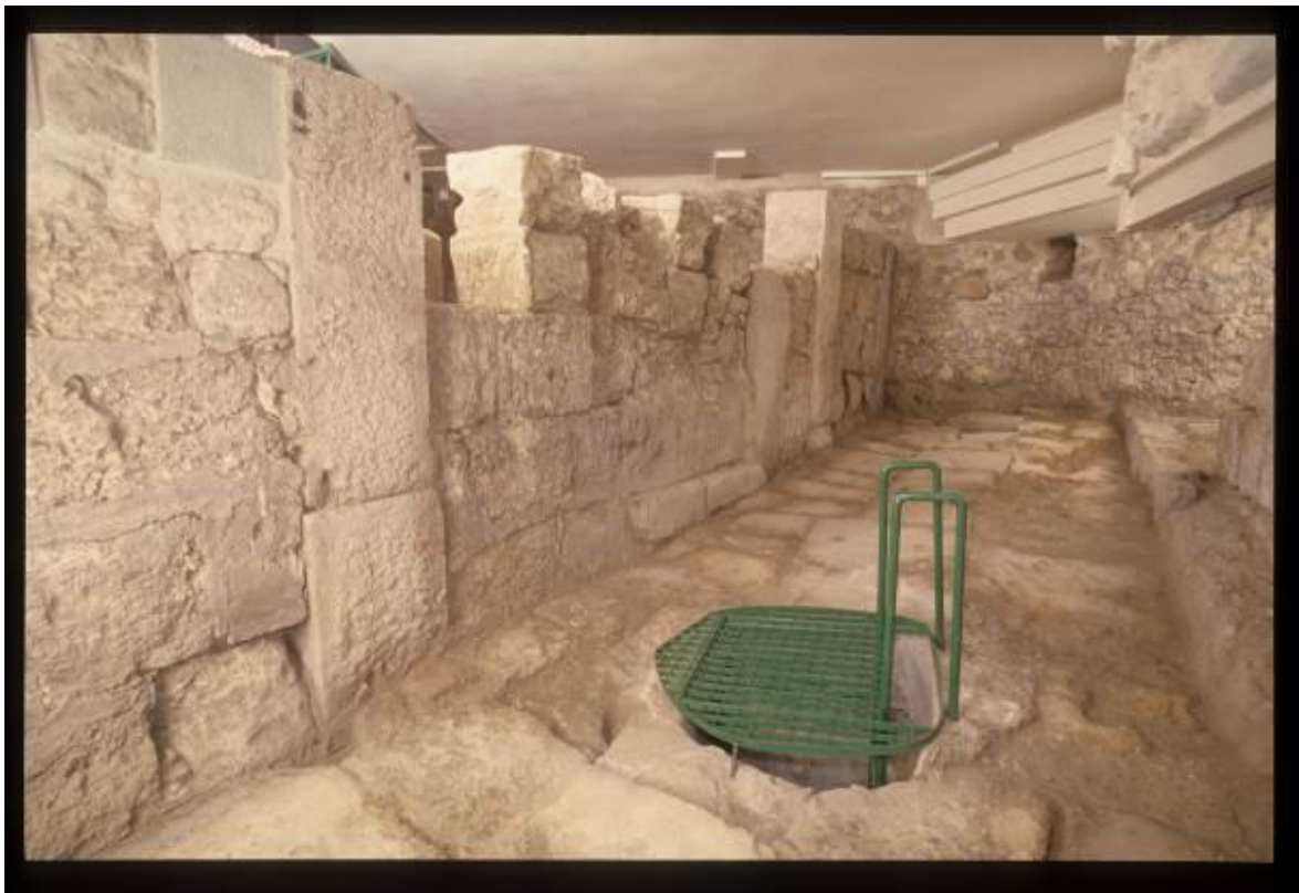
Fig. 3 - Muro a telaio delimitante il fianco sinistro della strada lastricata (foto di AFS).
