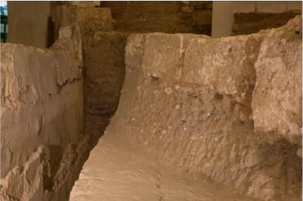
Fig. 1 - Setto murario dell'edificio costruito su uno spesso strato di sedimento. La sua continuazione poggiava sulle strutture rasate del portico (foto di Unicity S.p.A.).
