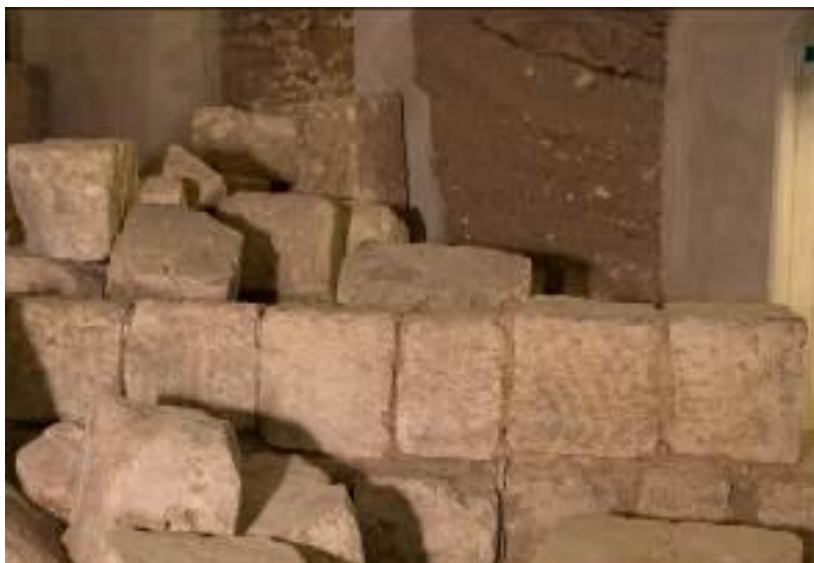
Fig. 1 - Muro trasverso costituito da blocchi di riutilizzo recuperati dal I crollo e innalzato su uno strato di cedimento nel portico (foto di R. MARTORELLI).
