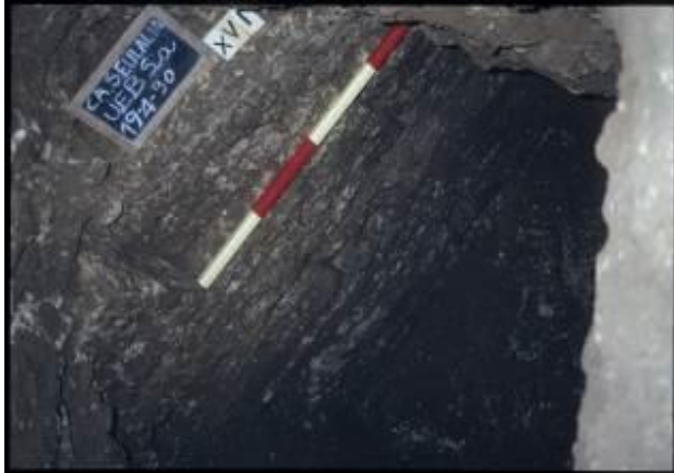
Fig. 2 - Tecnica muraria della canna rialzata (foto di AFS).
