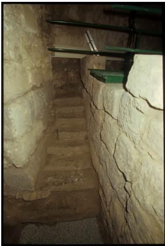
Fig. 1 - Abitazione a N-E: rampa a collegare il pianerottolo con latrina (foto di AFS).
