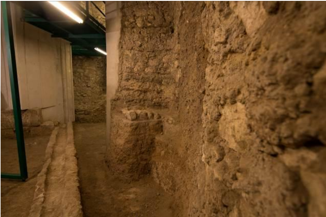
Fig. 3 - Canaletta attigua alle sostruzioni della chiesa (foto di Unicity S.p.A.).
