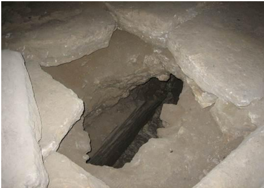
Fig. 1 - Condotto fognario durante le operazioni di scavo (foto di Unicity S.p.A.).
