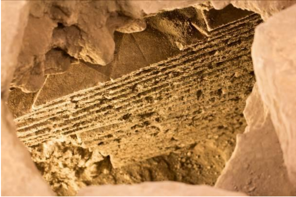
Fig. 2 - Rivestimento interno del condotto fognario (foto di Unicity S.p.A.).
