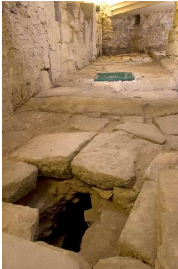
Fig. 1 - Pozzetto d'ispezione per la fogna, aperto sulla strada lastricata (foto di Unicity S.p.A.)
