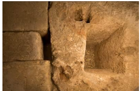
Fig. 2 - Pozzetto a pianta rettangolare risparmiato nel podio (foto di Unicity S.p.A.)
