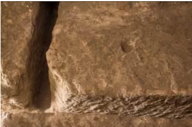
Fig. 3 - Particolare del taglio tra due blocchi calcare (foto di Unicity S.p.A.).
