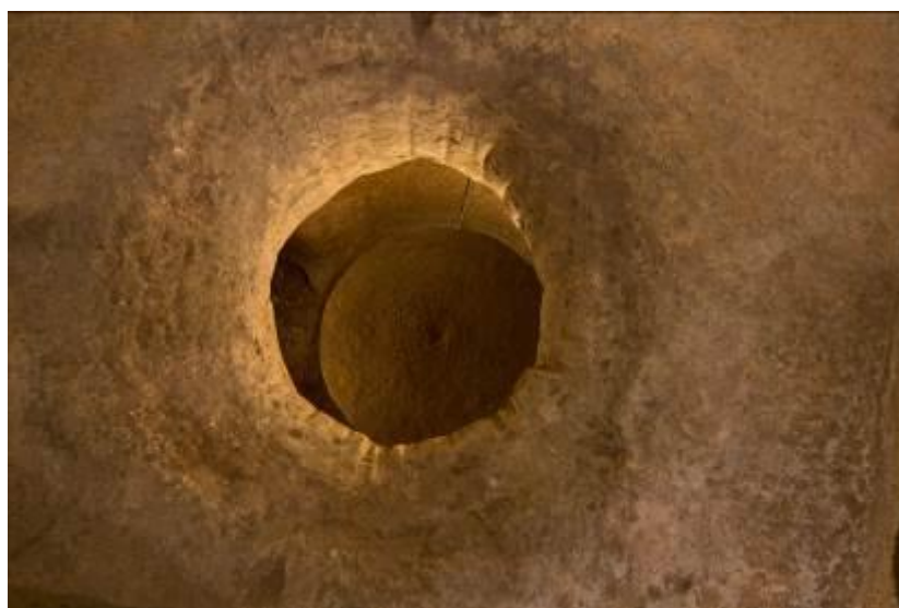
Fig. 6 - Imboccatura della cisterna a bottiglia (foto di Unicity).
