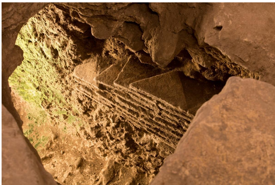
Fig. 3 - Tratto fognario in parte scavato nella roccia, in parte costruito con laterizi (foto di Unicity).
