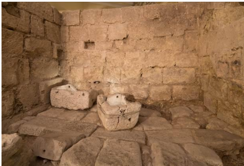
Fig. 4 - Ambiente interessato dalla sopraelevazione del piano pavimentale con l'apposizione di due vaschette litiche (foto di Unicity).
