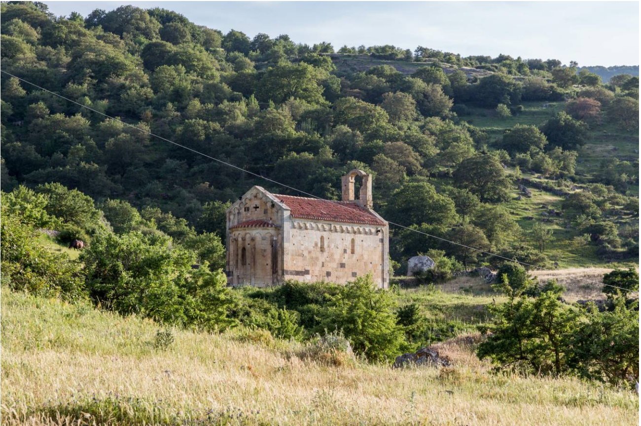
Fig. 1 - Panoramica dell'area in cui sorge la chiesa di San Lorenzo di Rebeccu (foto di Unicity S.p.A.).
