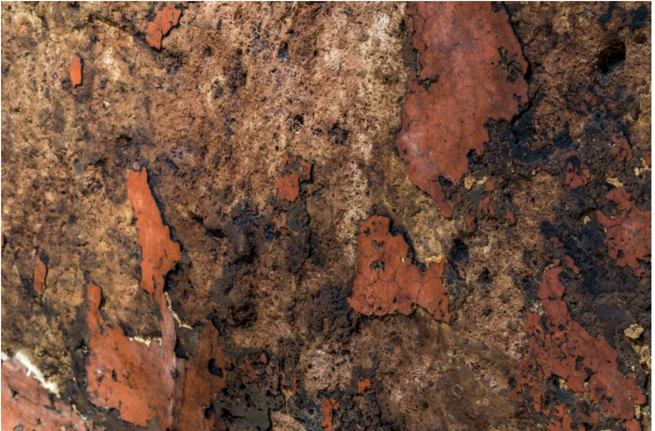
Fig. 6 - Tracce di ocra rossa presenti nel soffitto dell'endonartece (foto Unicity S.p.A.).
