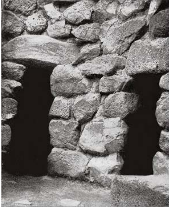
Fig. 2 - Particolare del cortile in cui si vede a sinistra la porta d'ingresso alla camera della torre C (da Lilliu 1962, Tavola LXIII.4, p. 335).
