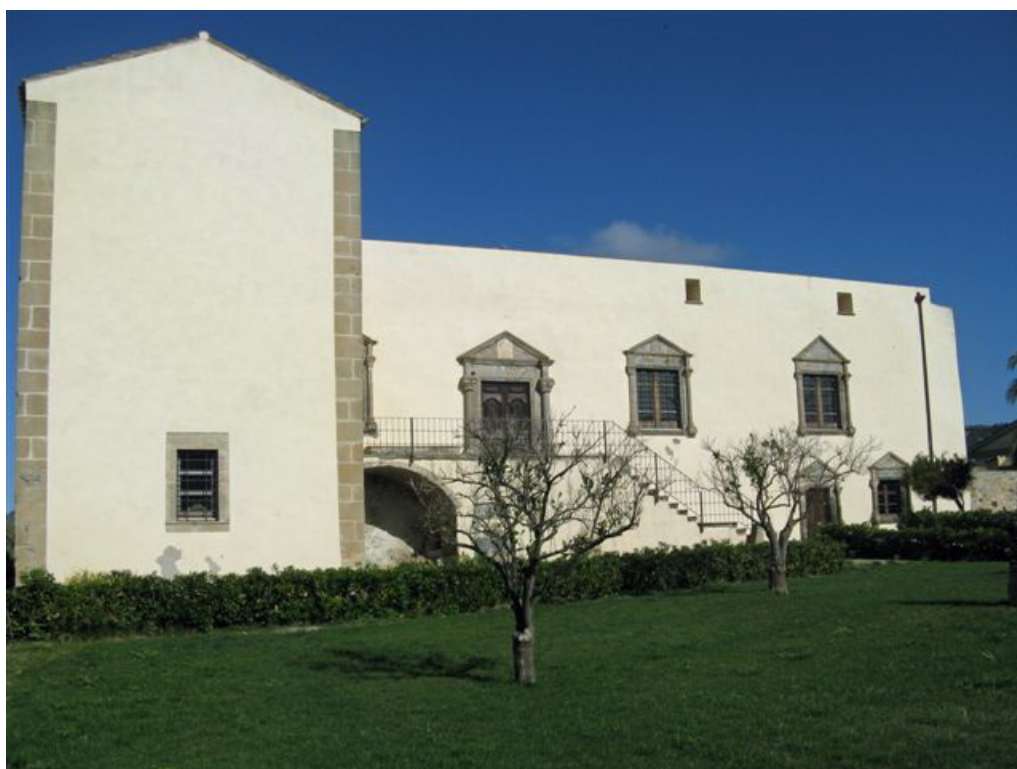
Fig. 1 - Il Polo museale "Casa Zapata" (da http://www.unionecomunimarmilla.it/VisitaTerritorio/fotoVisitaITerritorio/Barumini_Casa_Zapata.jpg ).
