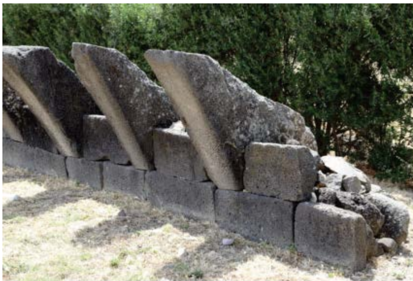
Figg. 2, 3 - Area archeologica di Su Nuraxi, mensoloni e conci a cuneo disposti secondo l'ipotesi ricostruttiva di Lilliu (foto di Unicity S.p.A.).
