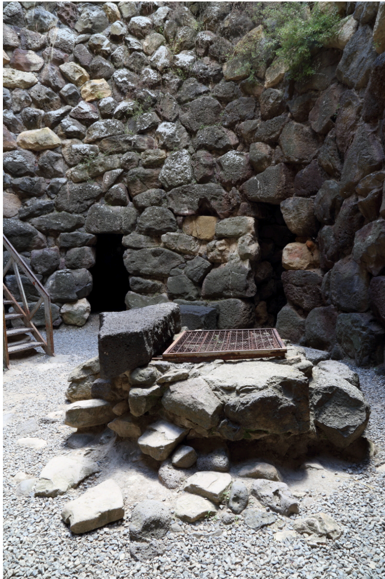
Fig. 6 - Il pozzo nel cortile (foto di Unicity S.p.A.).
