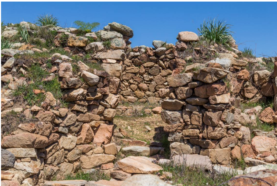
Fig. 6 - Vano 2 dell' insula 2 (foto di Unicity S.p.A.).
