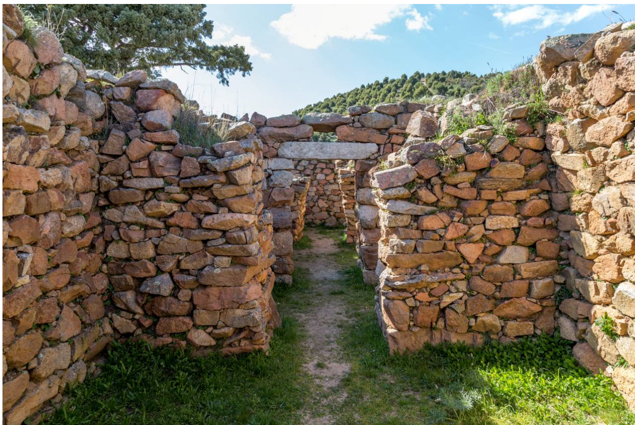
Fig. 1 - Corridoio di accesso al vano C del tempio a megaron 1 (foto di Unicity S.p.A.).
