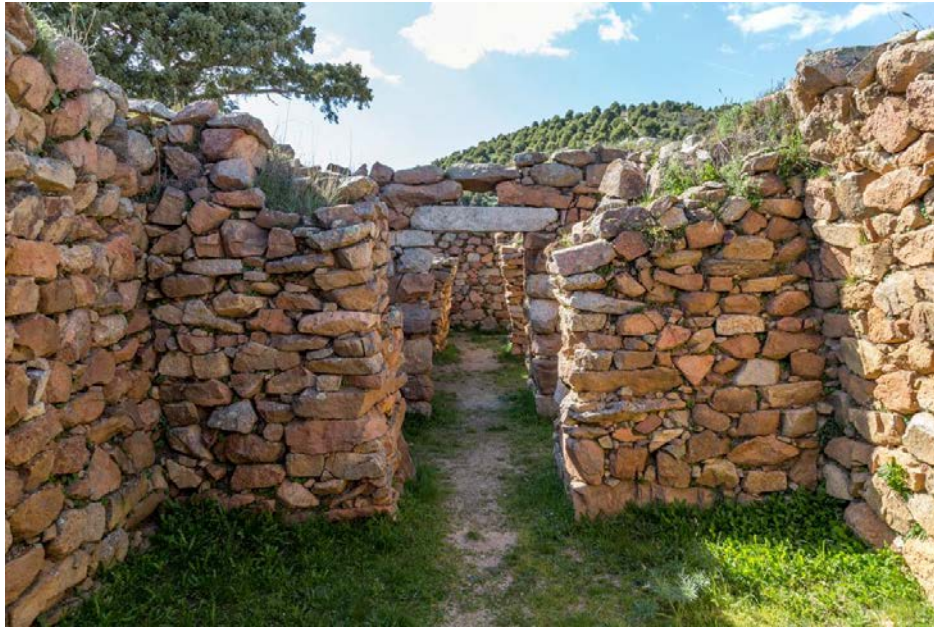
Fig. 3 - Particolare del corridoio di accesso al vano A (foto di Unicity S.p.A.).
