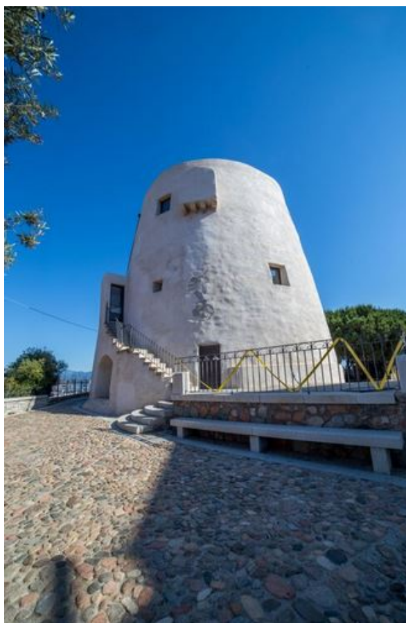
Fig. 6 - La torre di San Miguel (foto di Unicity S.p.A.).
