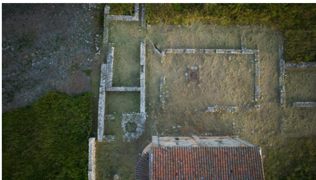
Fig. 1 - I resti del chiostro del monastero visto dall'alto (foto di Unicity S.p.A.).
