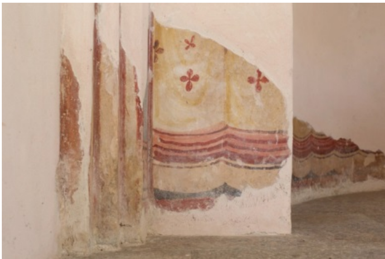
Fig. 1 - Il finto velario nella parte inferiore dell'abside (foto di Unicity S.p.A.).
