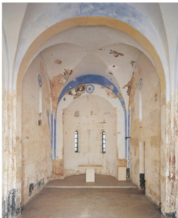
Fig. 3 - L'interno della chiesa di S. Nicola di Trullas prima dei restauri del 1997 (foto del Comune di Semestene)
