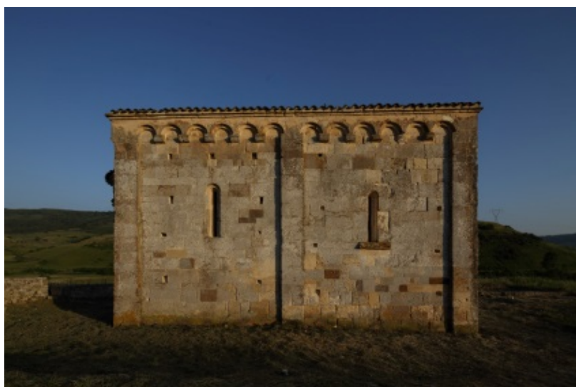
Fig. 2 - Lato settentrionale (foto di Unicity S.p.A.).
