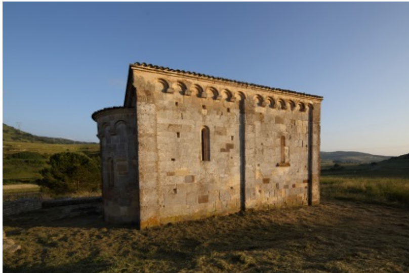
Fig. 1 - Lato settentrionale (foto di Unicity S.p.A.).
