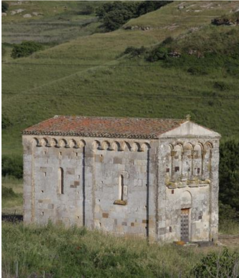
Fig. 4 - La chiesa vista da Nord-Ovest (foto di Unicity S.p.A.).
