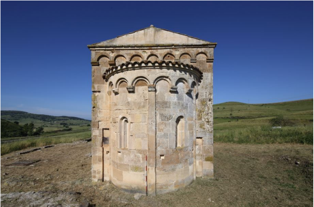
Fig. 4 - L'abside (foto di Unicity S.p.A.).
