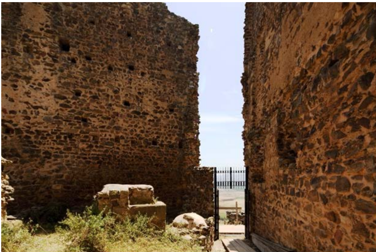
Fig. 1 - L'ingresso visto dall'interno del mastio (foto di Unicity S.p.A.).
