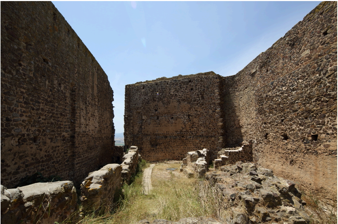
Fig. 11 - L'interno del castello visto da Est. Sui muri si notano i fori di alloggiamento per le travi lignee (foto di Unicity S.p.A.).
