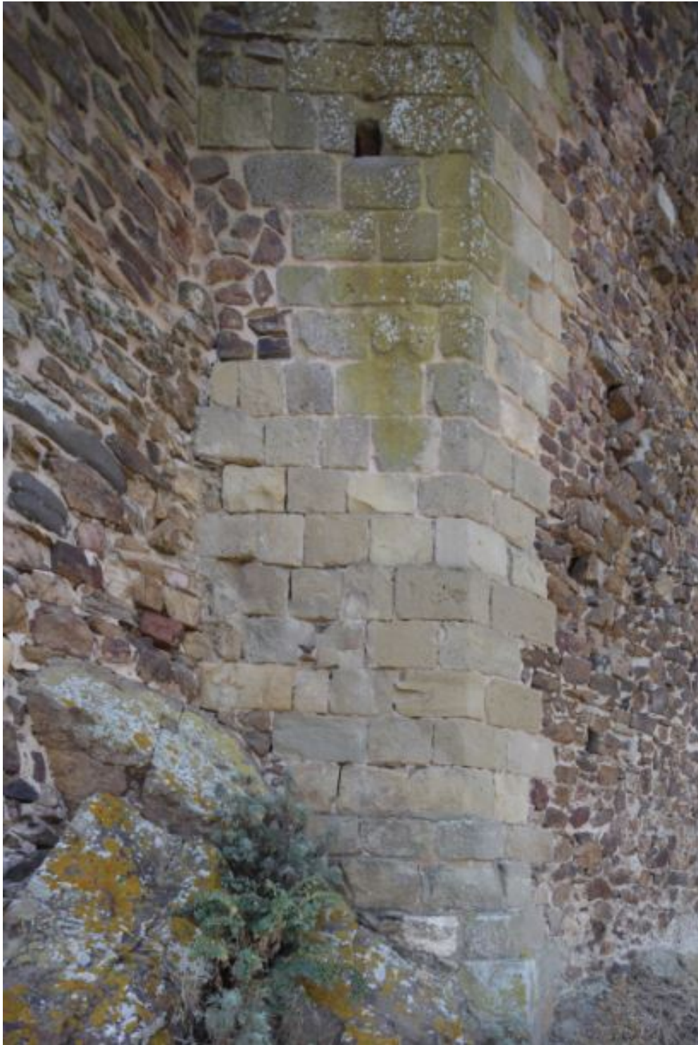
Fig. 12 - Particolare dell'opera muraria (foto di Unicity S.p.A.).
