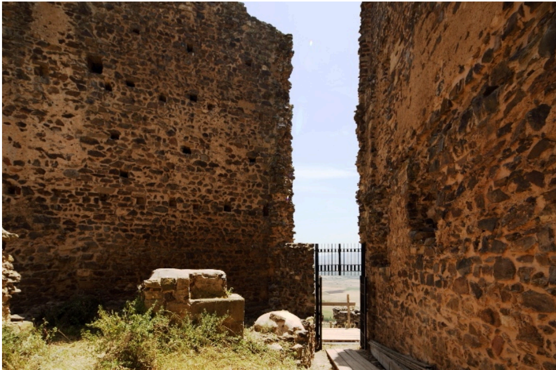
Fig. 8 - L'ingresso del mastio visto dall'interno dopo il restauro (foto di Unicity S.p.A.).
