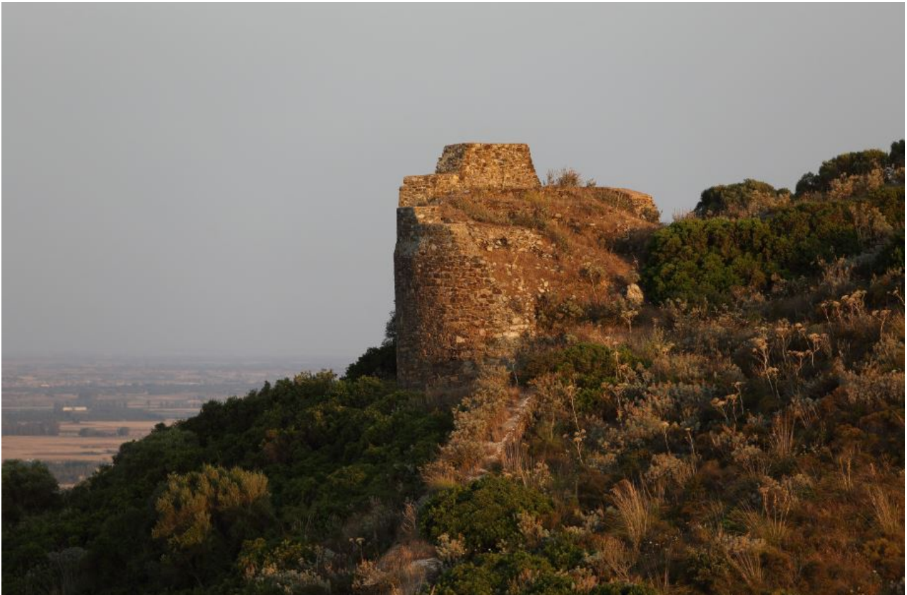
Fig. 4 - Una delle torri semi-circolari della cinta muraria del borgo (foto di Unicity S.p.A.).
