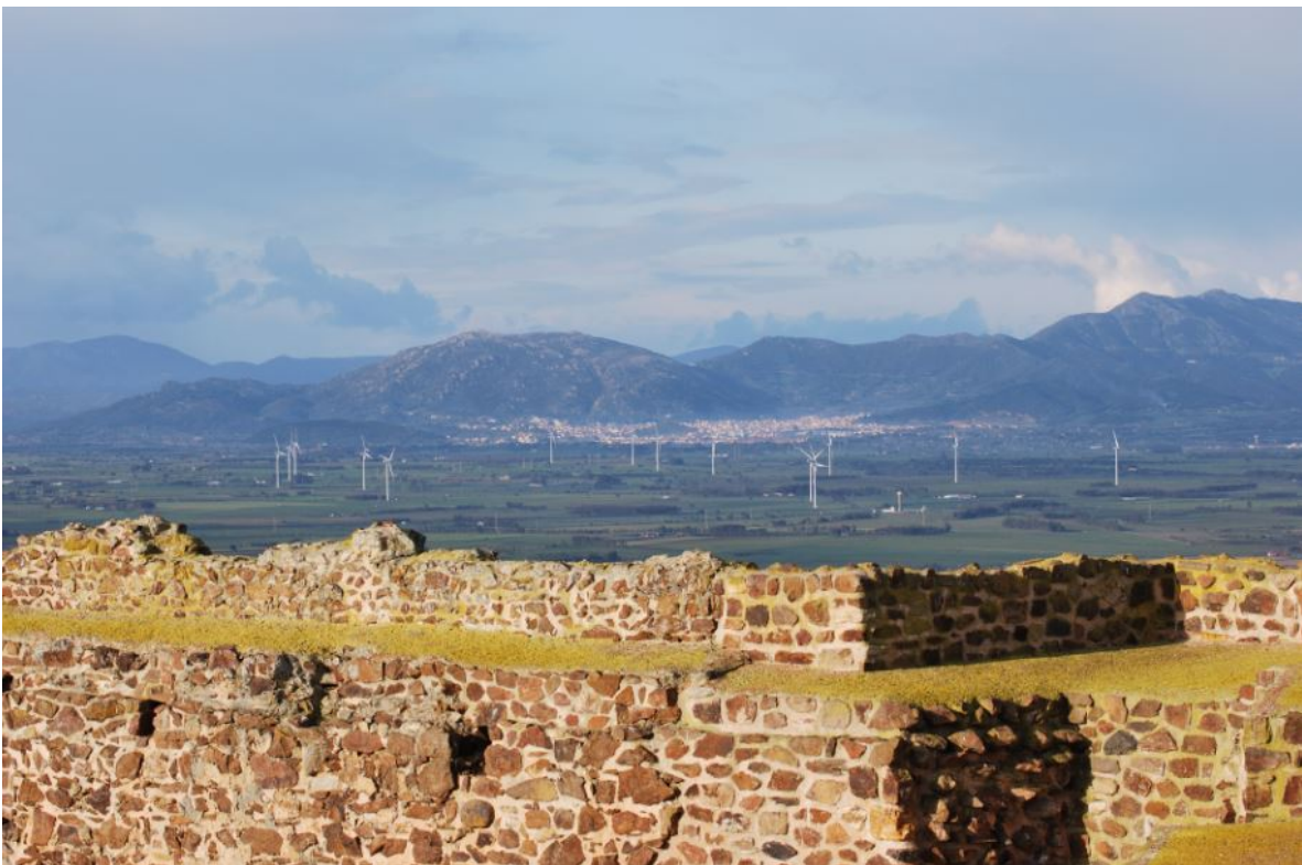
Fig. 10 - La parte superiore delle mura perimetrali del mastio con i camminamenti di ronda (foto di R. Bordicchia).
