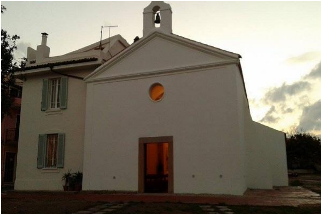
Fig. 3 - Chiesa di Santa Lucia (da http://www.penisolaitalia.com/ ).
