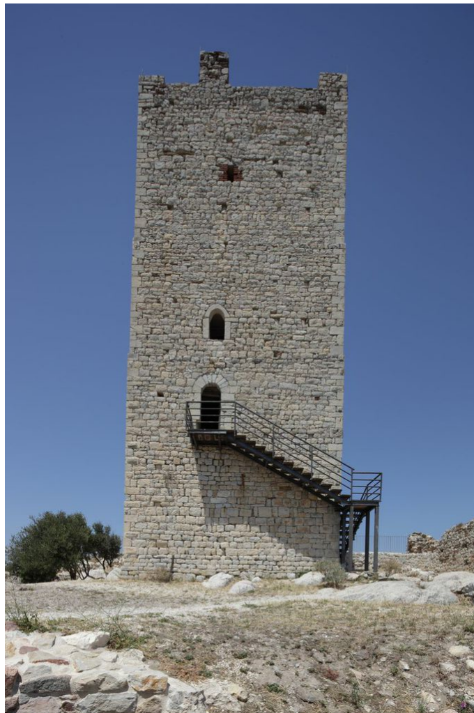
Fig. 1 - Ingresso principale alla torre, lato Est (foto di Unicity S.p.A.).
