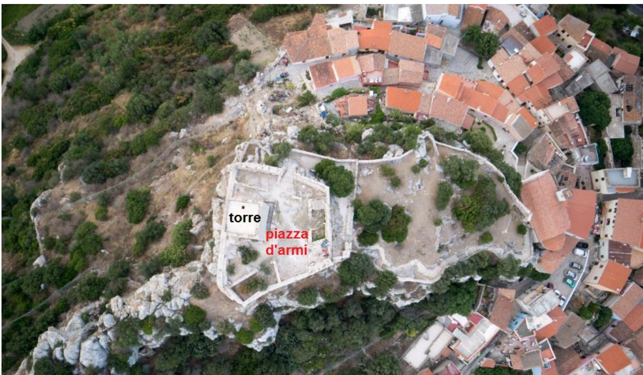
Fig. 1 - La rocca del castello della Fava con l'indicazione della piazza d'armi e della torre (rielaborazione di M. G. Arru, foto di Unicity S.p.A.).
