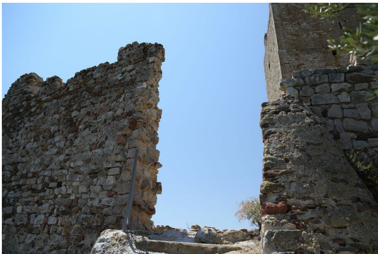
Fig. 2 - Alzato della cerchia muraria (foto di Unicity S.p.A.).
