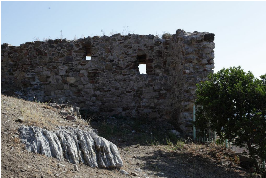
Fig. 3 - Aperture che interrompono la cortina muraria (foto Unicity S.p.A.).
