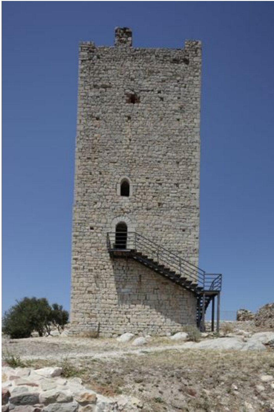
Fig. 8 - La torre del castello della Fava con l'ingresso rialzato rispetto al piano di calpestio della piazza d'armi (foto di Unicity S.p.A.).
