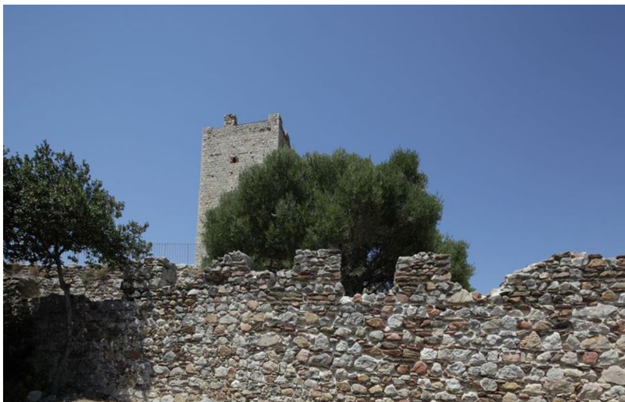
Fig. 7 - La cinta muraria e la torre del castello della Fava (foto di Unicity S.p.A.).
