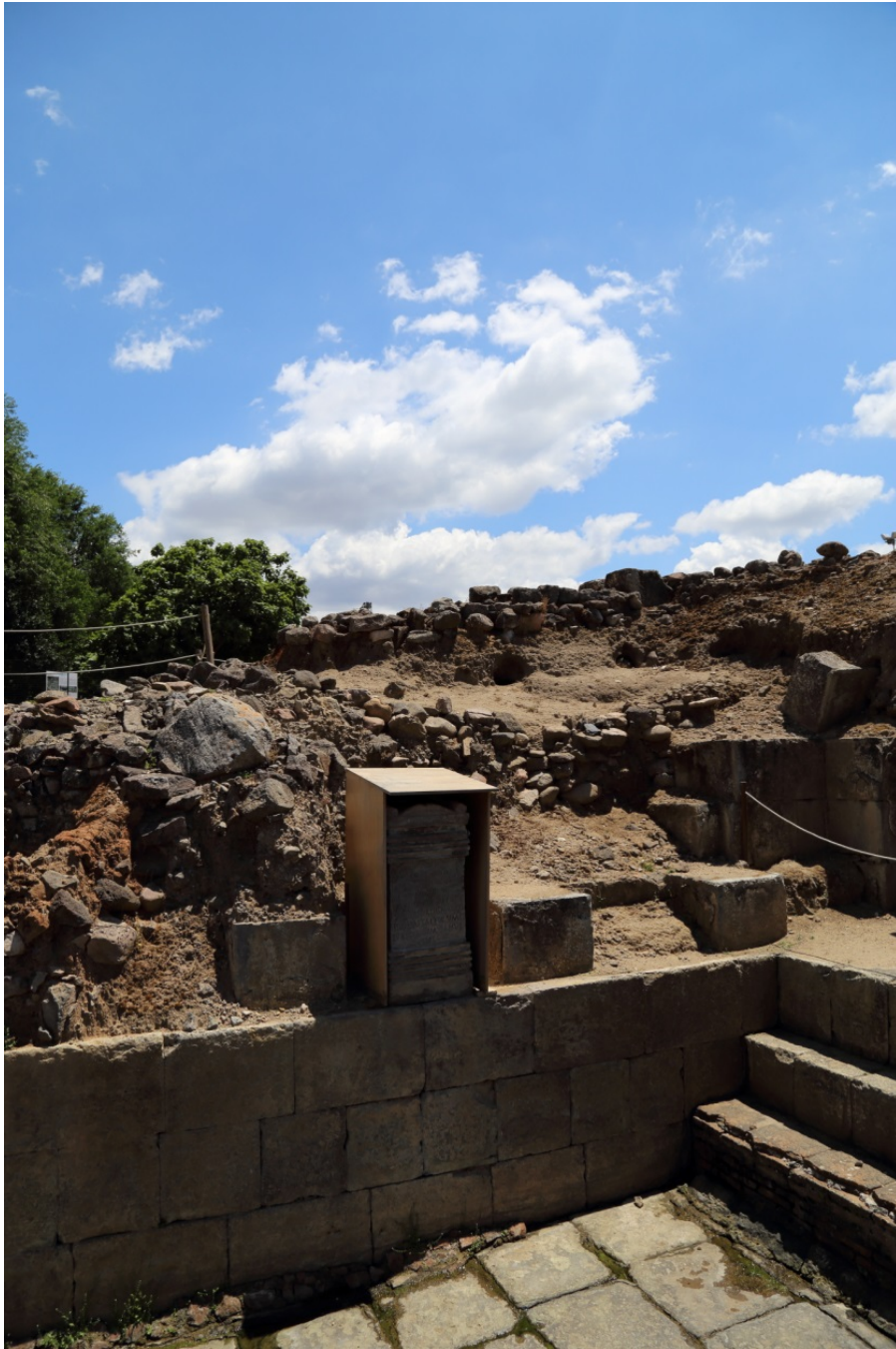
Fig. 4 - Veduta del Ninfeo con l'iscrizione ricollocata e protetta (foto di Unicity S.p.A.)
