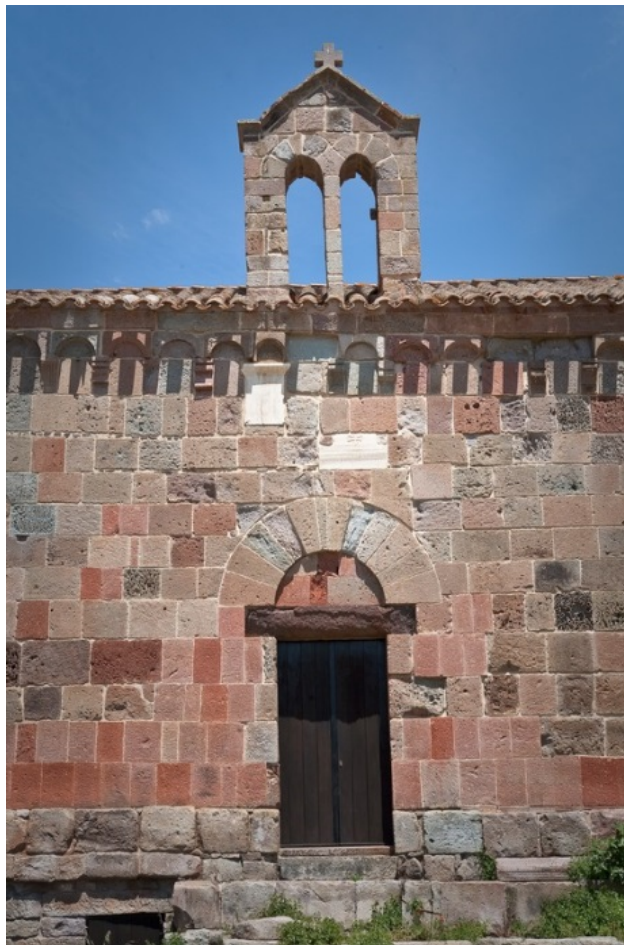
Fig. 1 - Facciata meridionale della chiesetta di San Lussorio, edificata nel XII secolo e ricostruita nel secolo successivo, a causa di un crollo (foto P. Dessì, Archivio R.A.S.).
