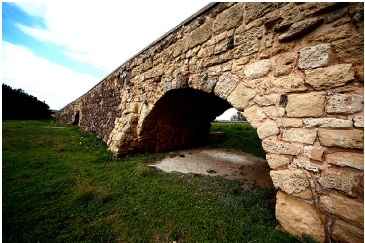
Fig. 3 - Sant'Antioco, ponte costruito sopra i resti del ponte romano (da https://www.flickr.com/photos/vincenzovacca/8367735306/in/set-72157632483827575 )
