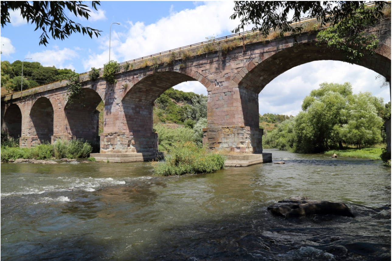
Fig. 4 - Ponte sul Tirso a Fordongianus: i piloni moderni sono impostati sul basamento dell'antico ponte romano (foto di Unicity S.p.A.).
