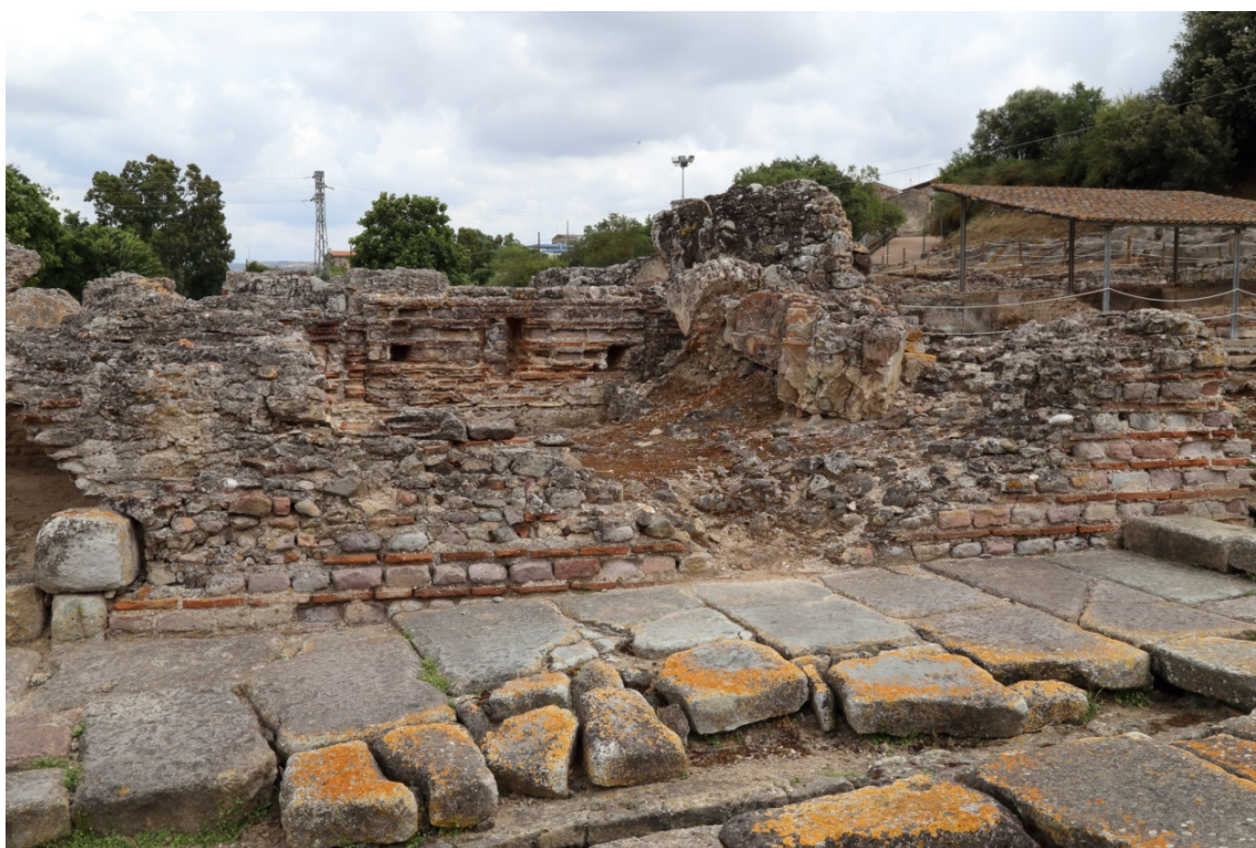
Fig. 4 - Edificio a L: casa di abitazione vista dalla piazza (foto di Unicity S.p.A.).
