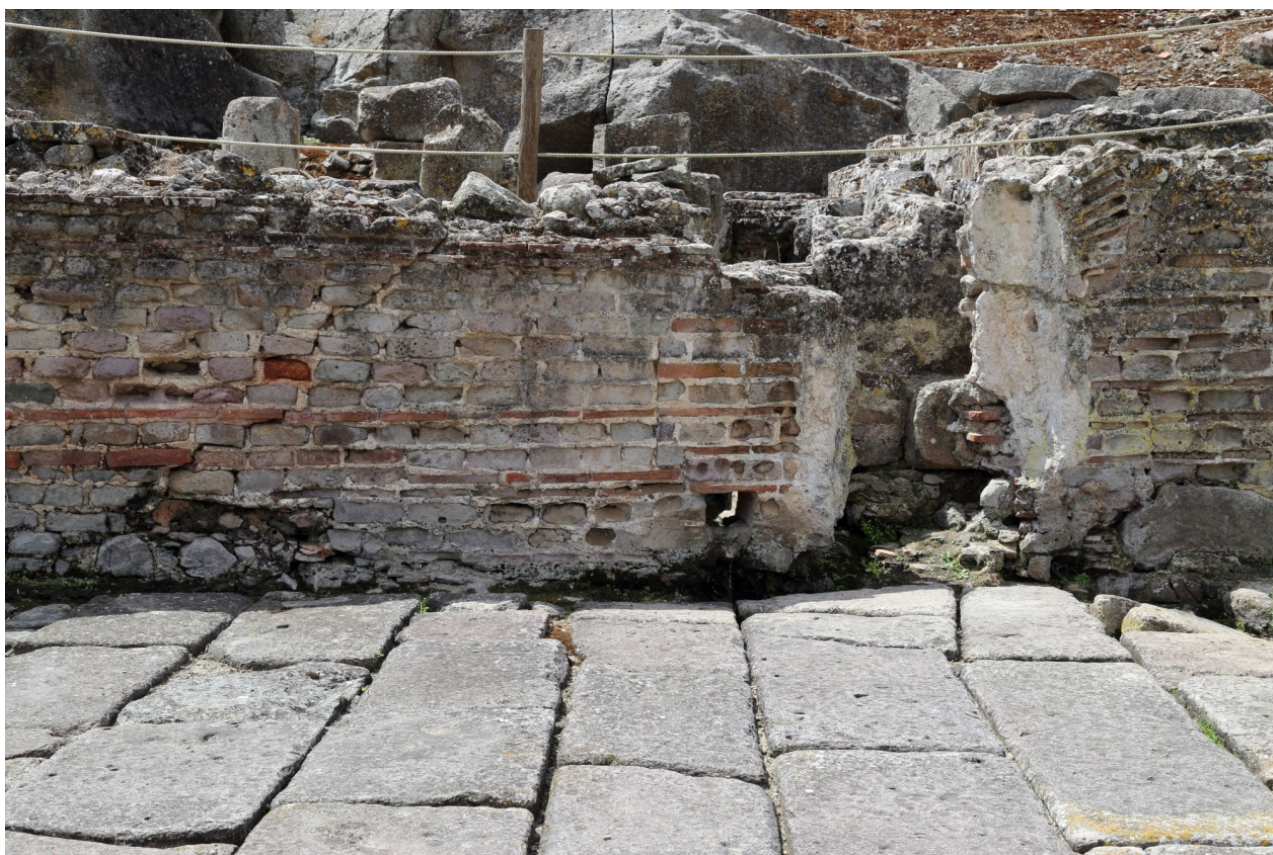
Fig. 5 - Il muro di chiusura della piazza sul lato meridionale (foto di Unicity S.p.A.)
