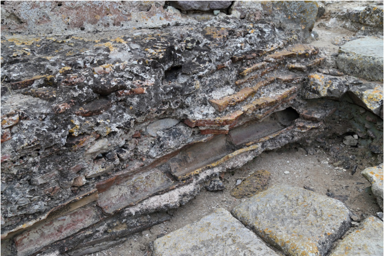
Fig. 3 - Canaletta in origine all'interno di una muratura (foto di Unicity S.p.A.).
