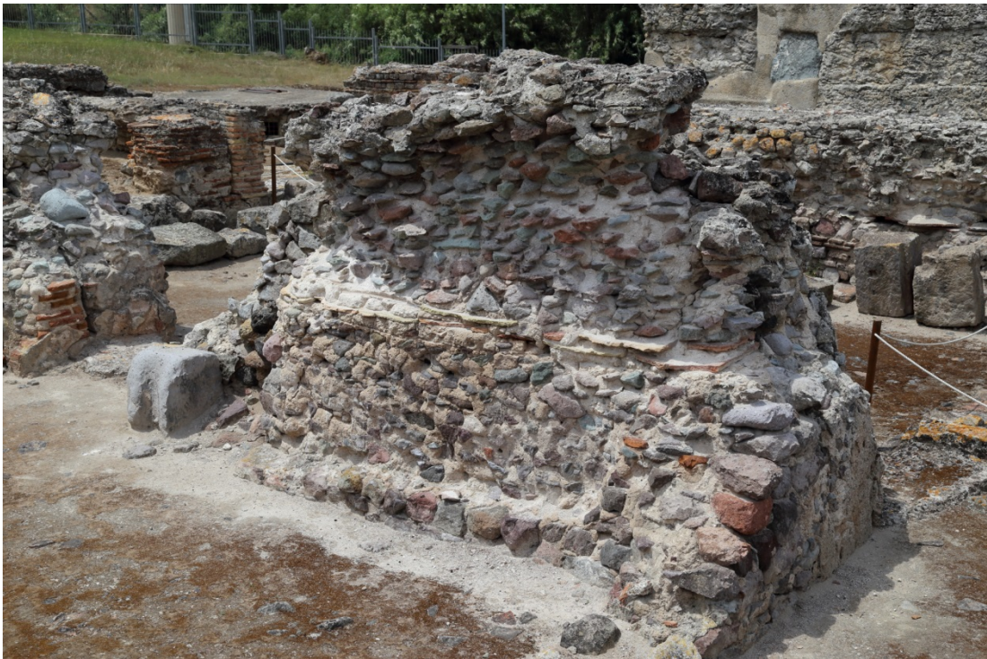
Fig. 4 - Parete del tepidarium con evidenti segni della forte erosione che ha messo a nudo la struttura interna del muro (foto di Unicity S.p.A.).
