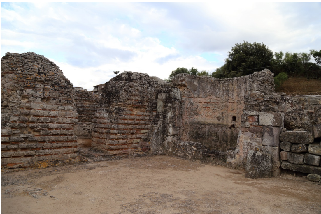
Fig. 3 - Dettaglio del frigidarium delle Terme II, con una vaschetta absidata (foto di Unicity S.p.A.).
