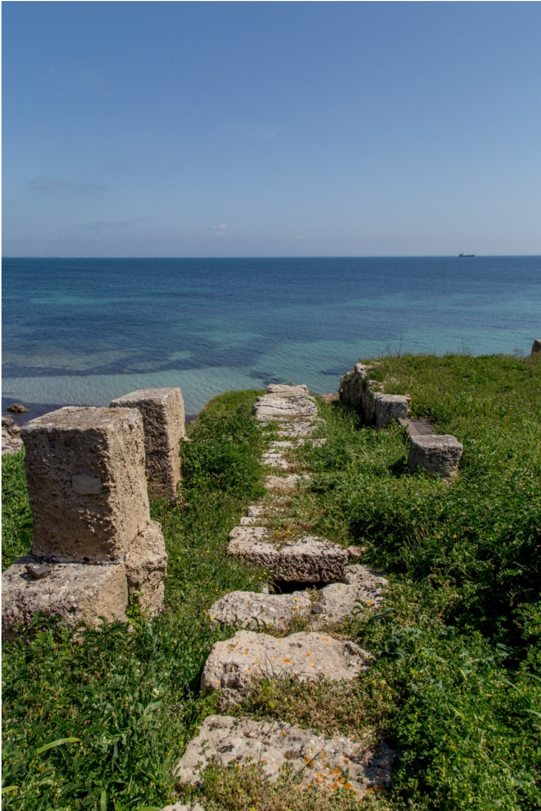
Fig. 10 - Fogna diretta verso lo scarico a mare (foto di Unicity S.p.A.)
