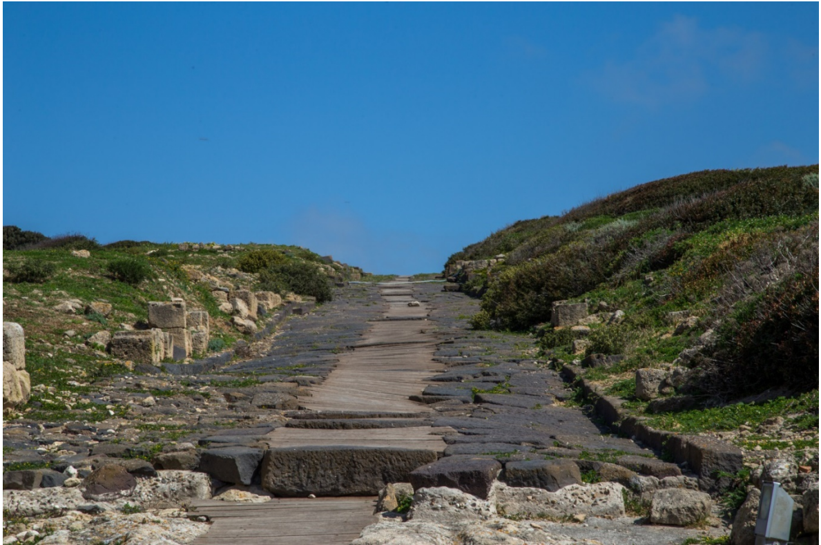
Fig. 8 - Strada romana: la copertura moderna in legno al centro riveste la cavità della fognatura (foto di Unicity S.p.A.)
