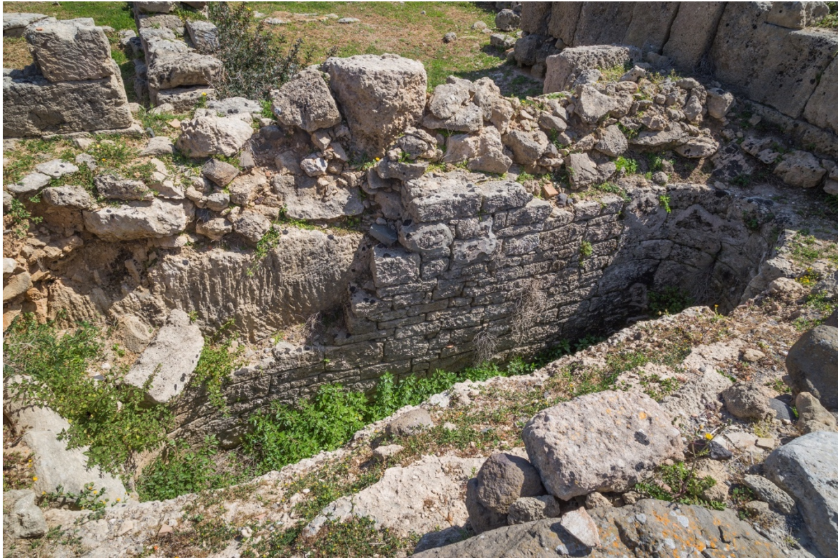
Fig. 3 - Cisterna a bagnarola (foto di Unicity S.p.A.)
